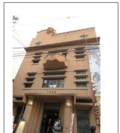
図3 京都大毎会館（現1928ビル）
