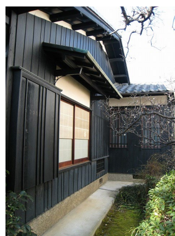
通気・掃出し用の開口
